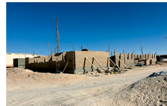
Les murs sont érigés. Le toit est monté.
