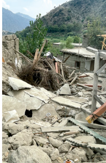
Village touché par le tremblement de terre.
