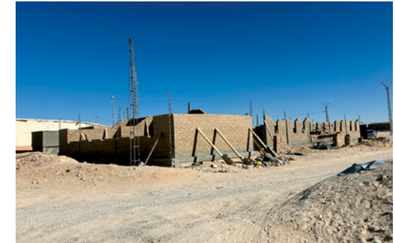
Die Mauern werden hochgezogen. Das Dach ist montiert.
