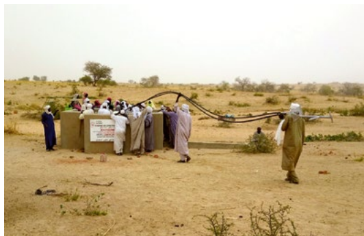
L'installation d'une pompe à eau requiert une grande habileté.
